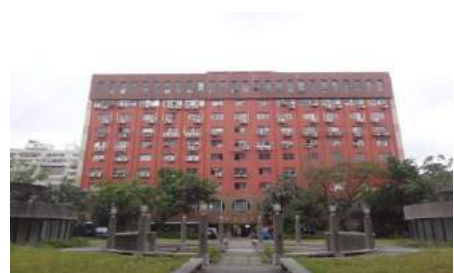
綜合大樓靠校園側
