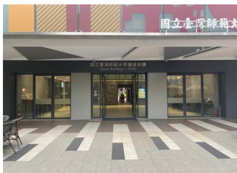
綜合大樓 1 樓門面改善(一)
