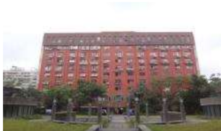
綜合大樓靠校園側
