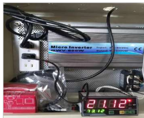
腳踏車發電設備發電量
